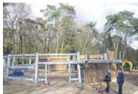
In 2014 startte de uitgebreide verbouwing van Het Berenbos. Ook de voormalige burcht werd compleet gesloopt en opnieuw opgebouwd.
